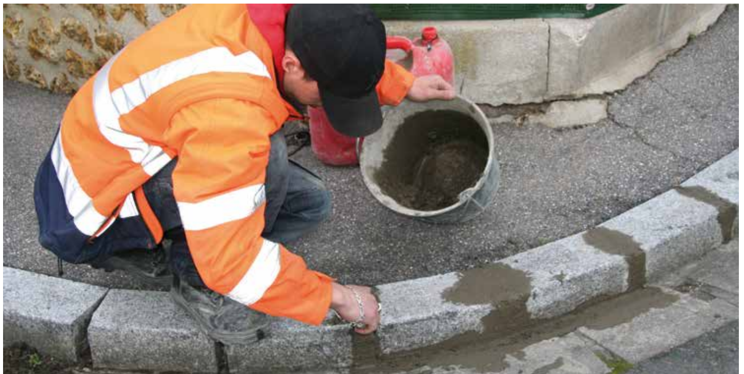
Réfection des trottoirs et bordures par les agents du service Voirie
