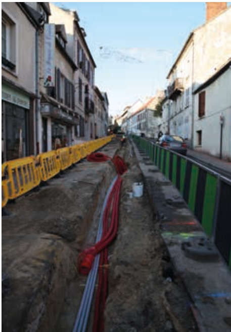
1- Passage des réseaux dans la Grande rue
