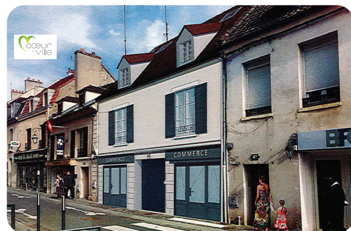
3 43-45 grande rue, la réhabilitation de 2 commerces et 13 logements est en cours de réalisation.
