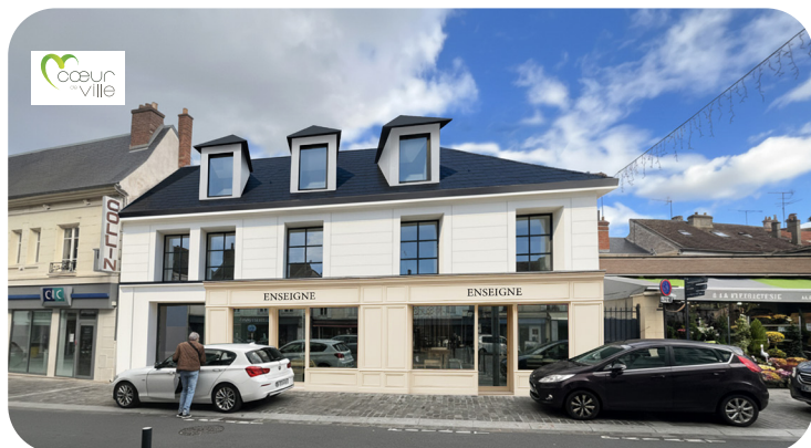
1 81 Grande rue, la réhabilitation complète de la cellule commerciale et 10 logements sur cour et sur rue a débuté.
